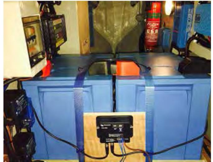
Das Foto zeigt 2 x 12,8 V 200 Ah Lithium-Eisenphosphat-(LiFePO4 oder LFP) Antriebsbatterien mit Zellenausgleich und BMS (in der Mitte).
